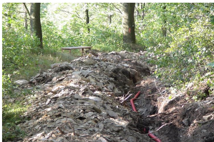
Svrchnice 24. srpna 2007 - položení napájecího kabelu pro nový vysílač jednoho nejmenovaného mobilního operátora.
